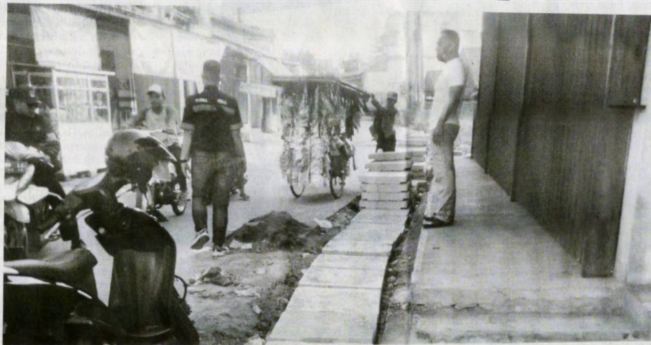
DIPERBAIKI: Drainase Dusun Cilalung, Desa Mekarjaya, Kecamatan Purwasari diperbaiki.
